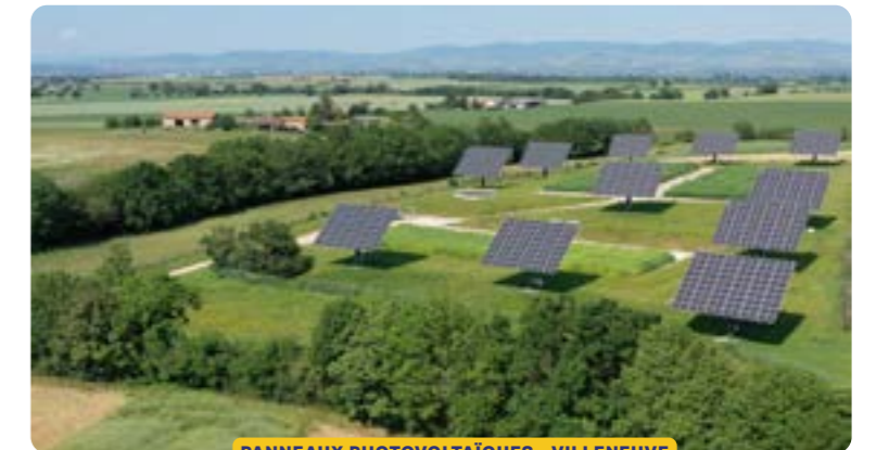
PANNEAUX PHOTOVOLTAÏQUES - VILLENEUVE
