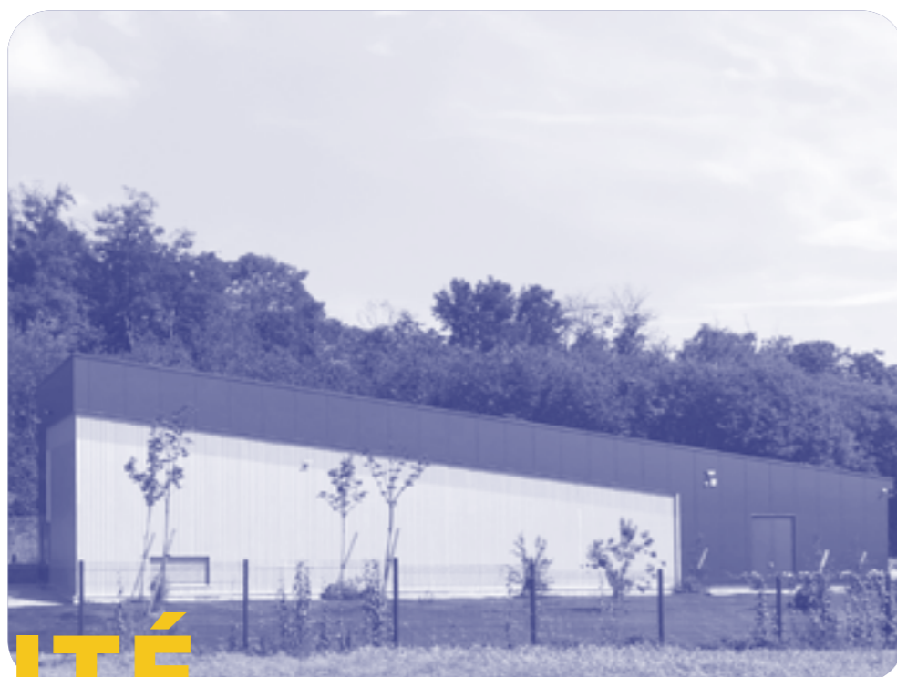
Poste source — Mionnay
